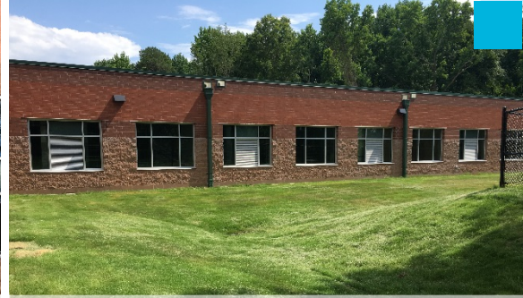
Morris Berg Architects
